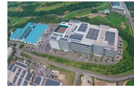
Solar power system (Kuwabata Plant)
